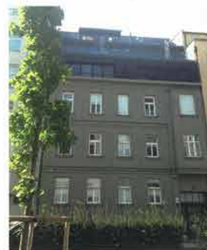
Obr. 5 Komplexná obnova bytového domu na Mytnej 25 v Bratislave, foto: L. Selcová
